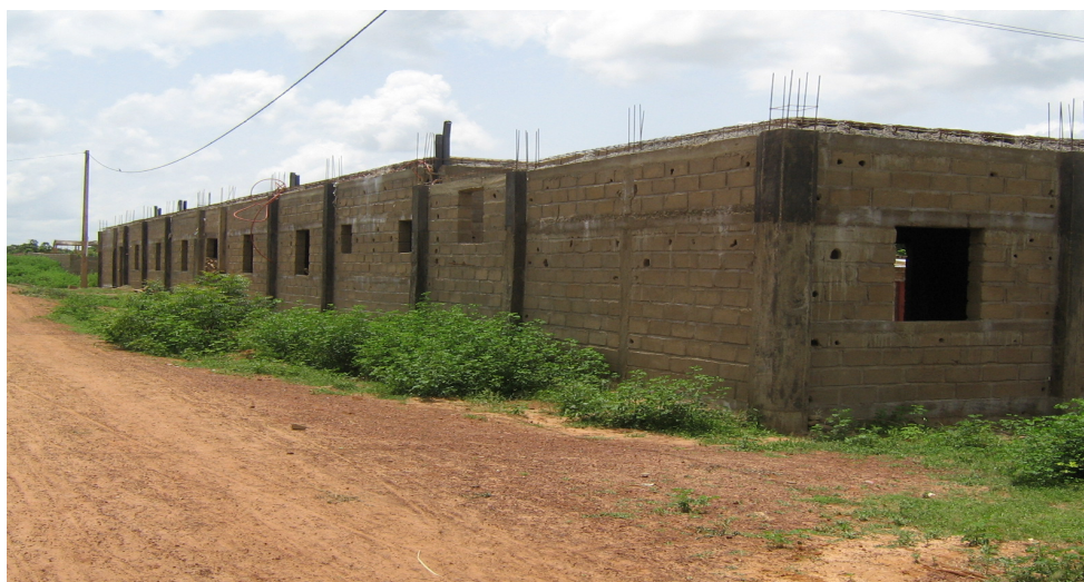
Le chantier de l'hôtel Yeleni à Sébougou
